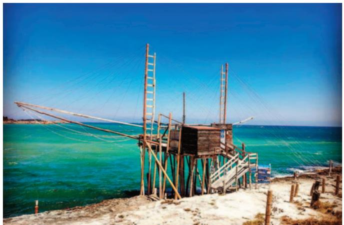
La rete, generalmente a bilancia, viene calata in acqua grazie ad un complesso sistema di argani, azionati elettricamente o a mano da almeno due uomini. Sul trabucco operano in norma quattro soggetti, detti traboccanti, predisposti all'avvistamento del pesce e alle varie manovre. Questo ingegnoso modus operandi permette di pescare senza inoltrarsi in mare.
